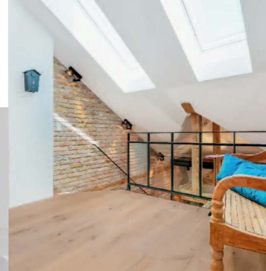
In Absprache mit dem Denkmalamt wurden funkgesteuerte, 3-fach verglaste Roto-Dachflächenfenster realisiert. Automatische Verschattungs- und Lüftungselemente werden zentral in Abhängigkeit von der Außentemperatur gesteuert.
